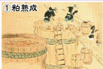
① 粕熟成 お酢の原料となる酒粕を大きな桶に入れ、長期間(3年ほど)寝かせ熟成させます。熟成することで、酒粕の甘みと旨みが増します。
