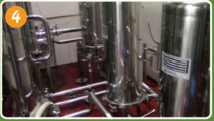
長い管を通し、熱を加えて殺菌する
